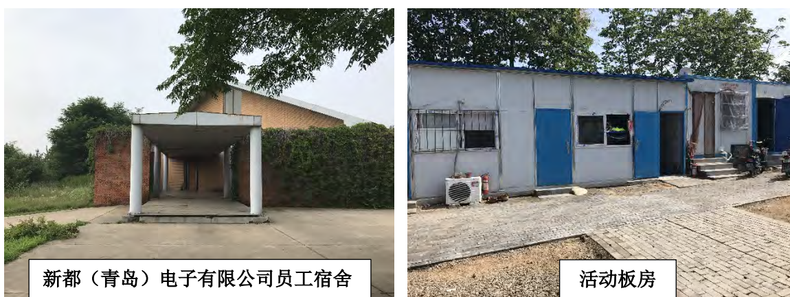
图 3.3-3 地块内 2 处生活区现场调查照片
